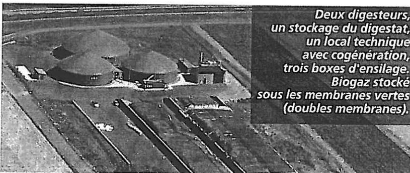
Deux digesteurs, un stockage du digestat, un local technique avec cogénération, trois boîtes d'ensilage. Biogaz stocké sous les membranes vertes (doubles membranes).
